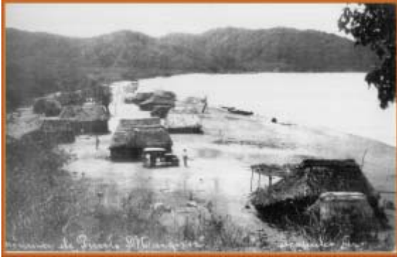
Puerto Marques era un sitio sin infraestructura urbana rodeado de selva tropical seca. Foto cortesía de C. Adame O.
