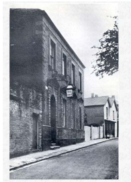
En su juventud A.R. Wallace trabajó con su hermano John en proyectos arquitectónicos. El edificio que fue del Instituto de Mecánica de Neath. Imagen: www.en.wikipedia.org
